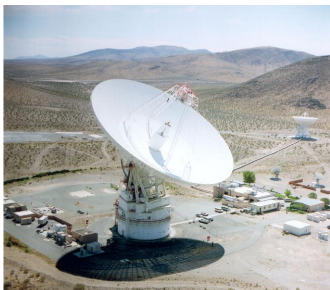
Fig. 18 Reflector parabólico de 70 metros de diámetro en Goldstone, California: antena de elevada directividad capaz de recibir señales muy débiles de fuentes lejanas de nuestro espacio. Cuanto mayor es el tamaño del reflector 5 , más capacidad para recibir señales del espacio exterior
