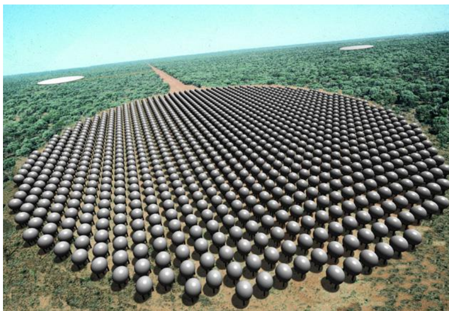
Fig. 32 Agrupación de antenas tipo lente (material dieléctrico) con la finalidad de captar potencia de fuentes muy lejanas en el espacio exterior [13]
